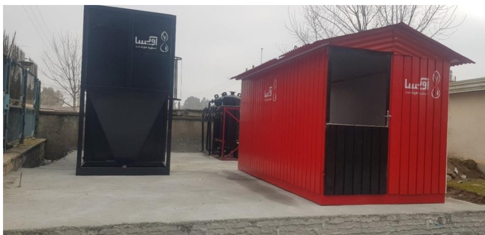
تصویر (۳-۹) طراحی و اجرای تصفیه‌خانه مرکز همایش‌های علمی دانشگاه تهران واقع در خزرآباد
